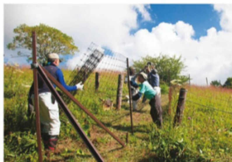
三ツ峠での防鹿柵設置作業
